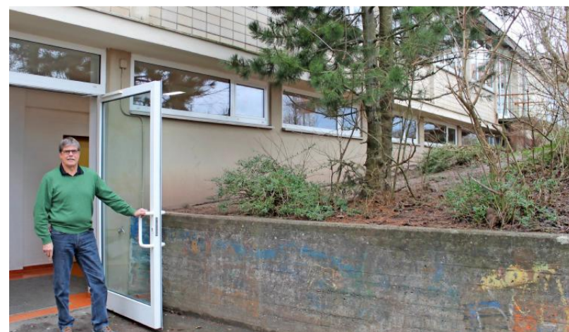
Rektor Peter Wagner an der künftigen Baustelle. Wo Mauer und Grün sind, werden zweigeschossig je ein Klassenzimmer mit kleinem Lernatelier errichtet.
